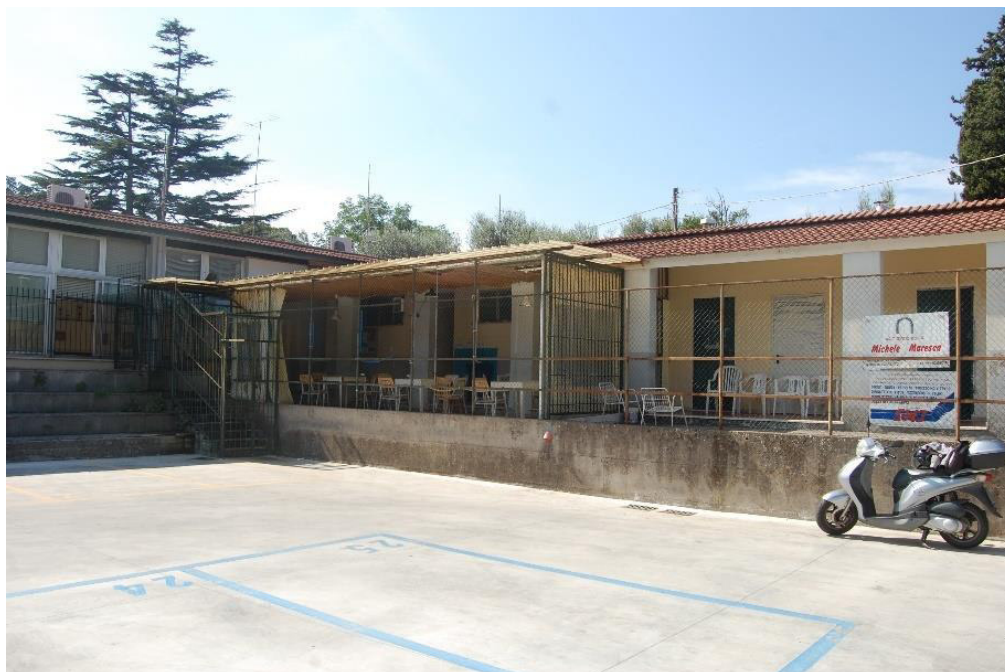
Figura 17 – Struttura esistente, complesso sportivo "Le Querce"
