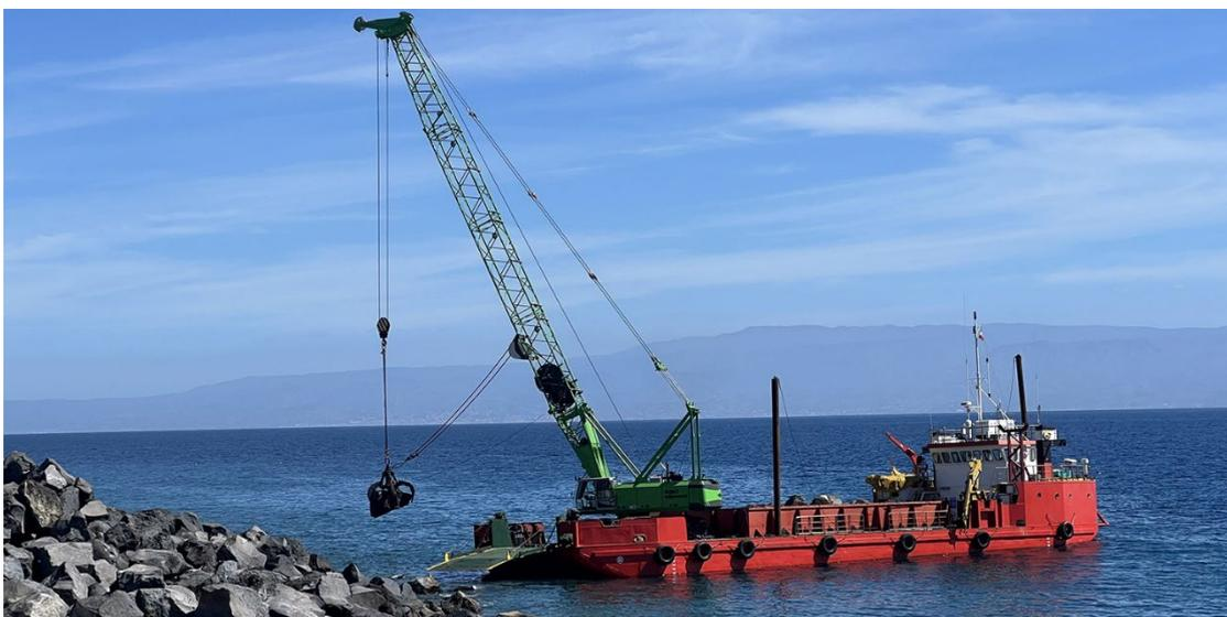
Figura 3 – Esempio della modalità di lavorazione per la sistemazione degli scogli con motopontone.
